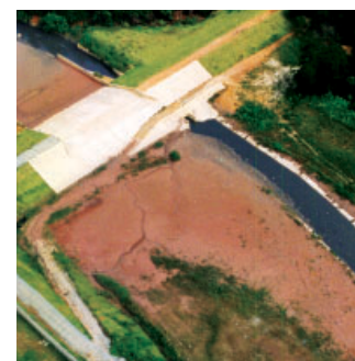
Canal artificial aberto
