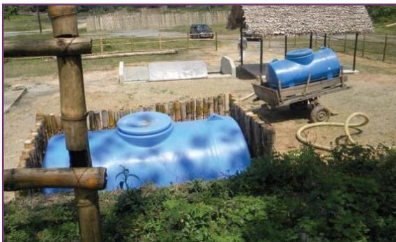
*Lit de séchage solaire des boues et citerne de vieillissement*
