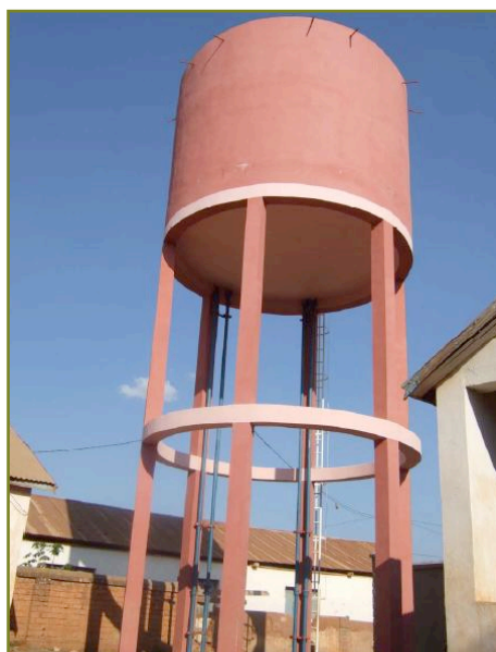
Le réservoir de 50 m3 réalisé (© Sanea)
