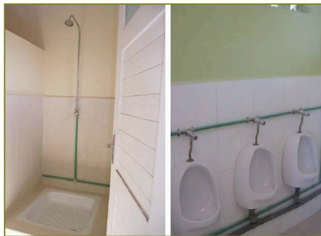
Blocs sanitaires réalisés dans le collège (©Sanea)
