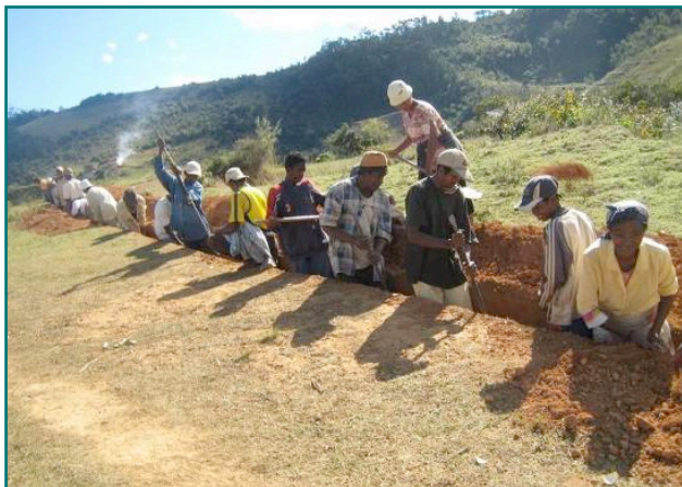
Réalisation des tranchées pour la pose des conduites à Alakamisy-Itenina (© Grand Lyon)
