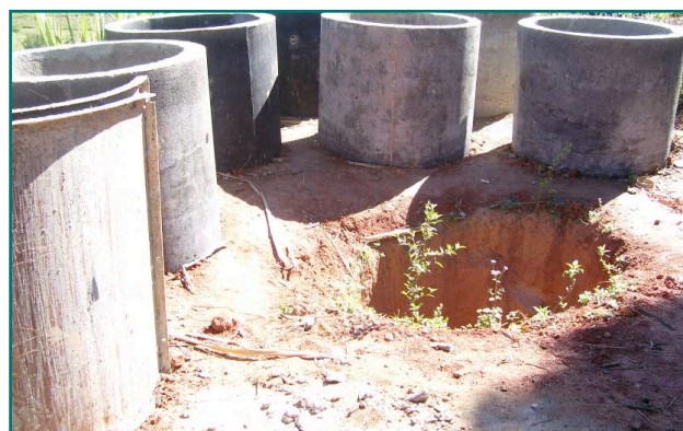
Réalisation sur place des buses pour équiper les puits, à Fianarantsoa (© Grand Lyon)
