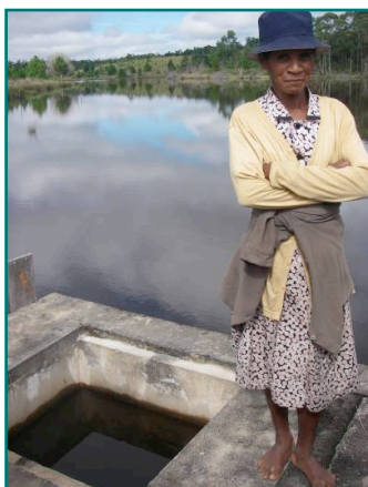
Surveillance du barrage d'Antarambivy, à Fianarantsoa (© Grand Lyon)
