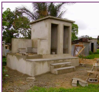
Modèle de latrine sur fosse septique (séparation parties sèches/liquides), avec système de chasse d'eau constituée d'une pompe à main (©Areed)
