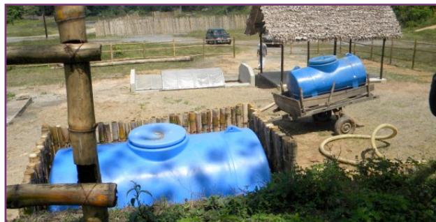
Lit de séchage solaire des boues et citerne de vieillissement (© Areed)
