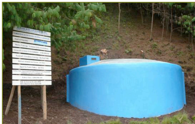
Le réservoir de "tête" du réseau d'Ambohibary (©Mathieu Le Corre)
