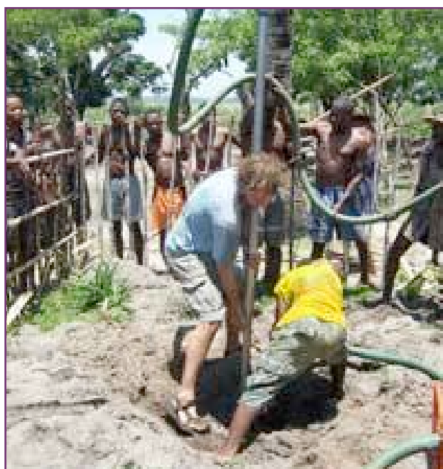
Exécution du forage par pression "well jetting" (© Bushproof)
