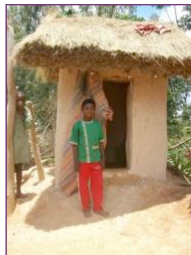
Latrine construite à Vinaninony
