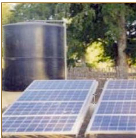
*Panneaux solaires produisant l'énergie électrique pour le pompage et réservoir (©Fondem)*
