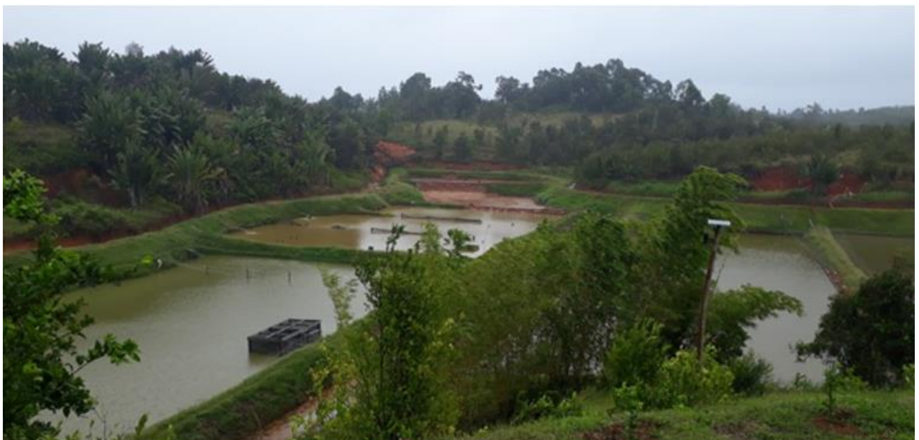
Photo d'un barrage de retenue pour pisciculture à Andranoala, District de Vatomandry, Région Atsinanana
