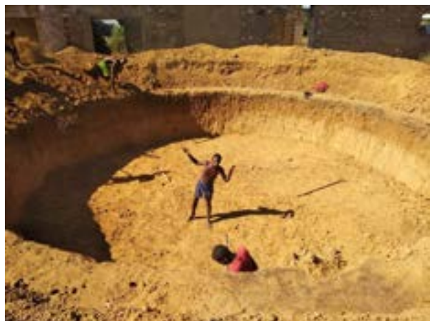
Fouille pour la fondation d'un château d'eau (Befandriana, mai 2022)
