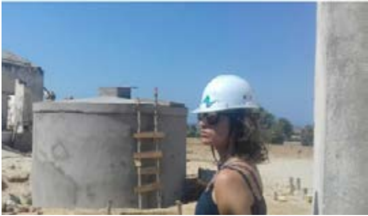
En haut : Inspection du nouveau réservoir d'eau à Tsihake par Aurélie Buffo, consultante d'Experts-Solidaires (Tsihake, mai 2022)
