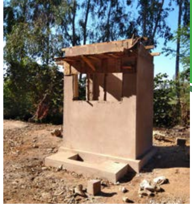
A droite : Nouveau kiosque à eau à Ankiliabo dans le cadre de l'extension du réseau d'Ankililoaka (Ankililoaka, mai 2022)
