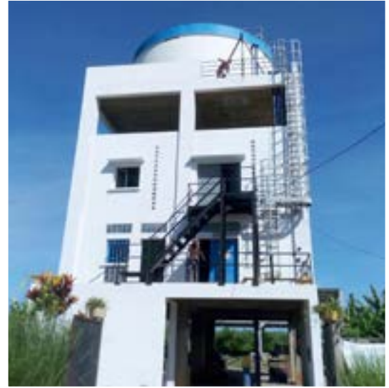
Local bureau, station de déferrisation et le réservoir sur tour de 100 m 3
