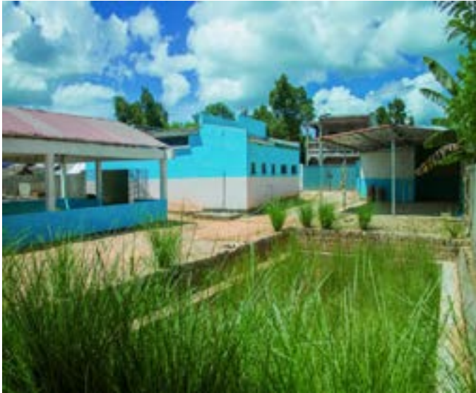
Station de traitement de boues de vidange (vue sur le filtre planté)
