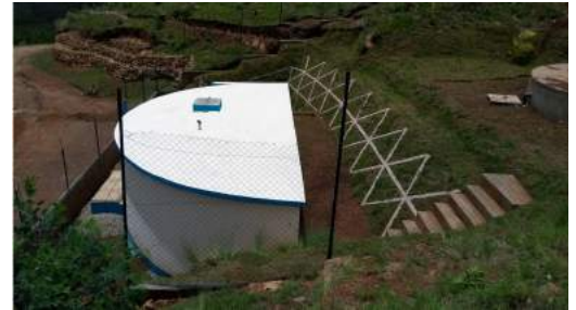
Réservoir de 110 m 3 et local de traitement
