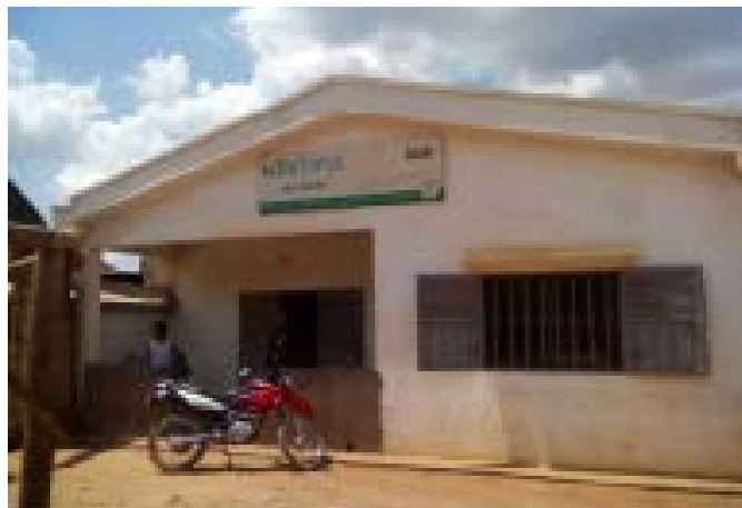
Figure 22 : Bâtiment de l'OTIV
