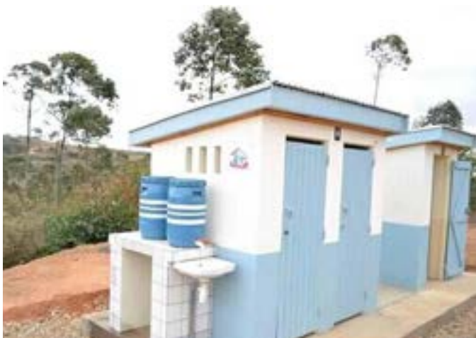
Figure 23 : DLM installés dans le lycée du chef-lieu Sadabe
