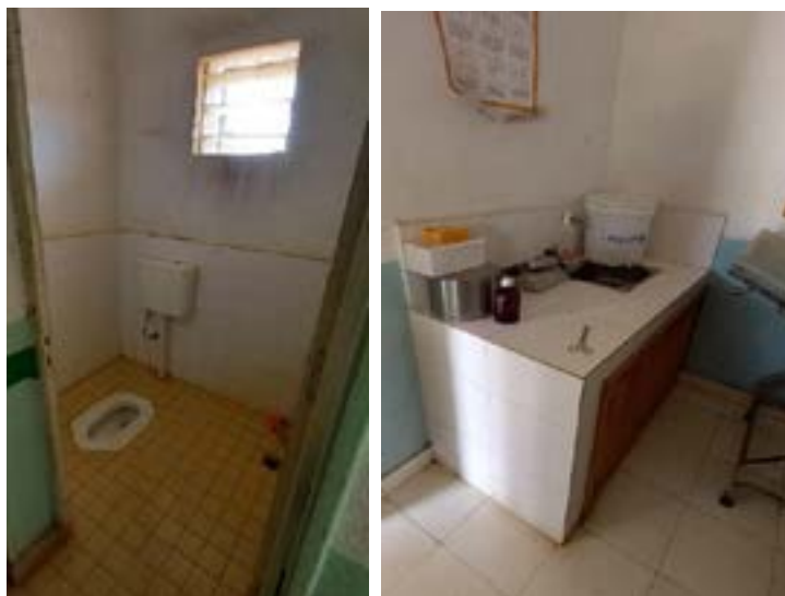
Figure 90 : Les infrastructures en EAH dans le CSB II Anjanadoria
