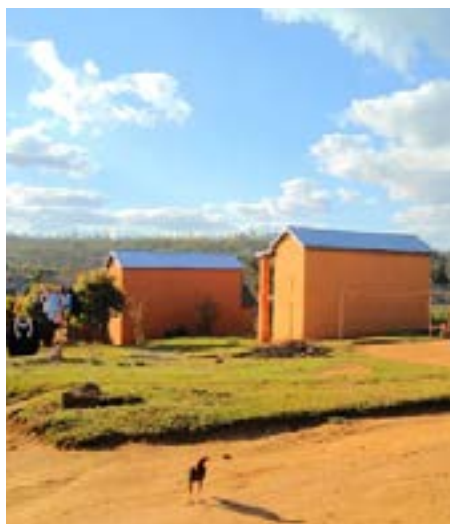
Figure 3 : Des maisons en terre battue avec une toiture en tôle
