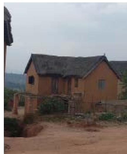
Figure 4 : Des maisons en terre battue avec une toiture en tôle
