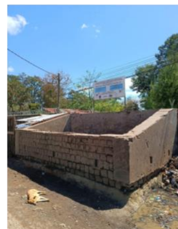
Bac à déchet construit par l'ONG EAST
