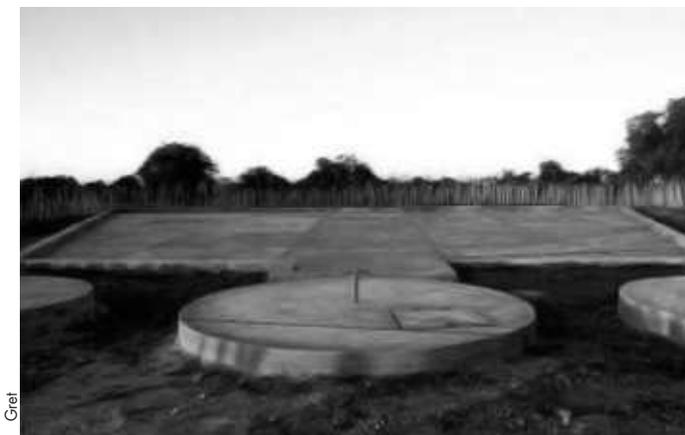
Impluvium construit par Objectif Sud à Ankiliabo. De la surface de récupération, l'eau de pluie s'écoule vers un bassin désableur (au centre de l'image) puis vers 3 bassins de stockage (au premier plan)
