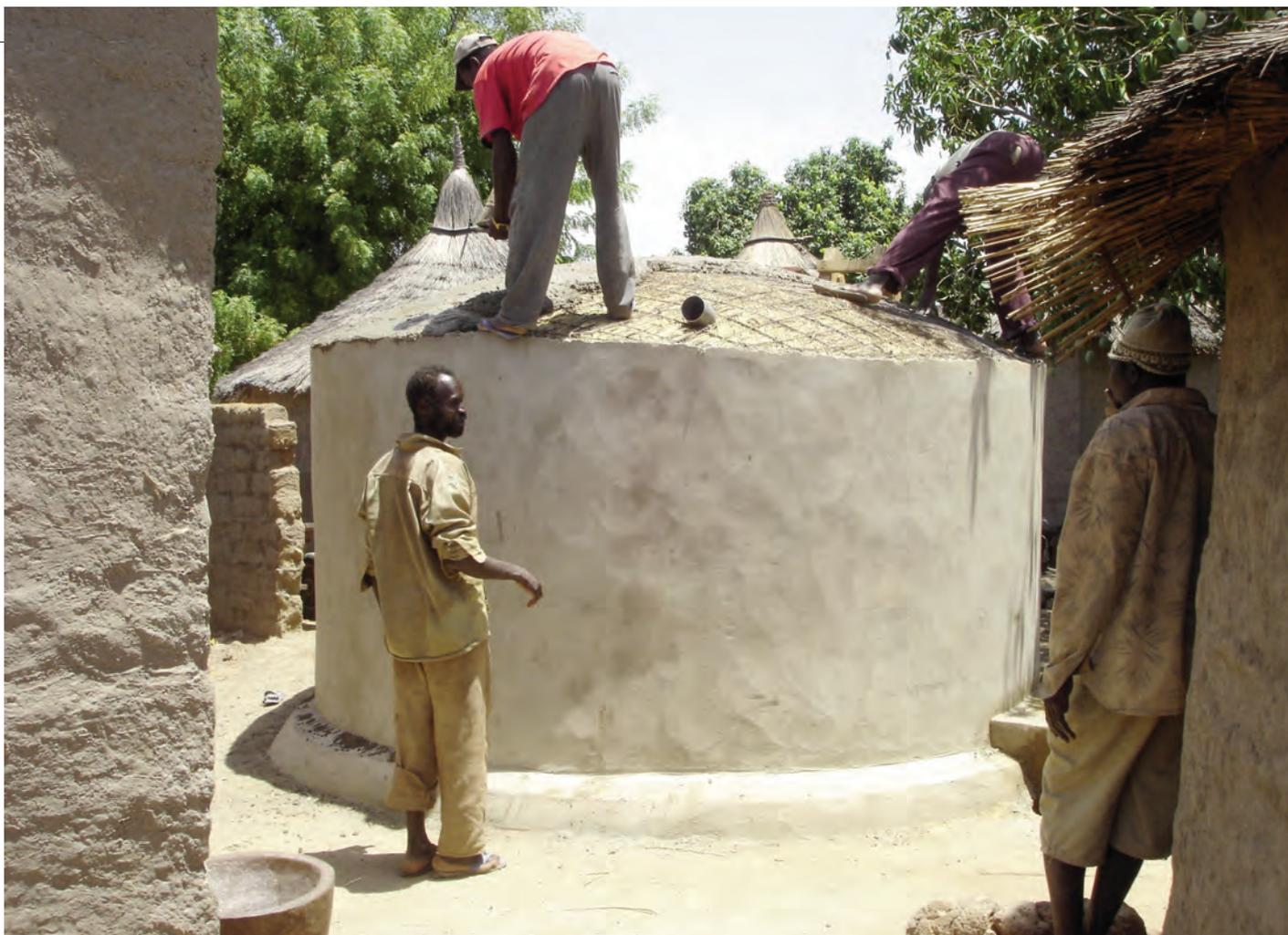
D'une capacité d'environ 10m<sup>3</sup>, les citernes hors sol collectent les eaux de pluie des bâtiments munis d'un toit en tôle galvanisée.
