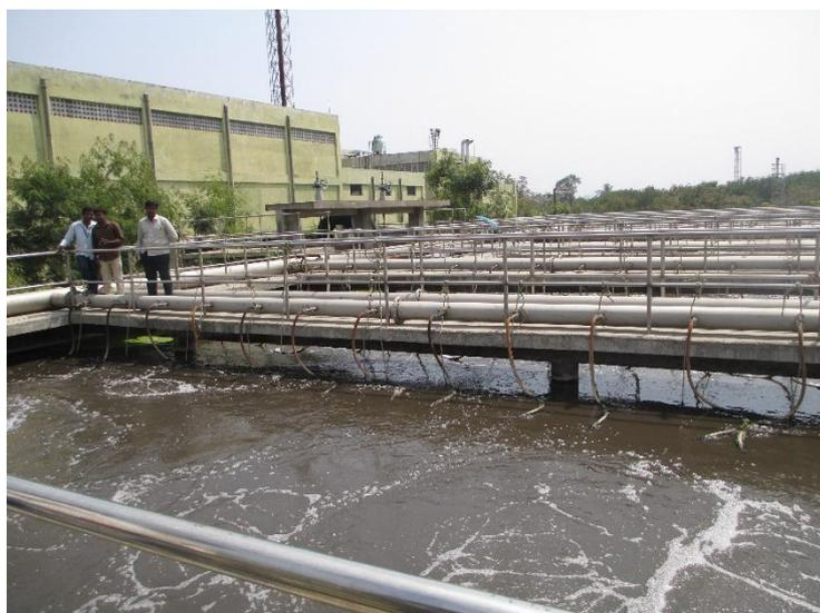
Cette station de traitement des eaux usées importante permet un co-traitement des boues de vidange avec les eaux usées, avec une capacité totale de 117 000 m<sup>3</sup>/j pour les eaux usées et 1 800 m<sup>3</sup>/j de boues de vidange.
