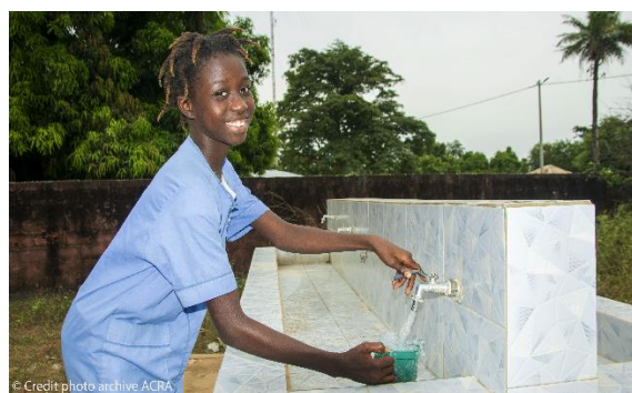
Borne fontaine installée à l'école élémentaire de YOUTOU
