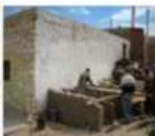
2 - Construction des chambres et coffrage
