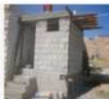
4 - Construction de la superstructure
