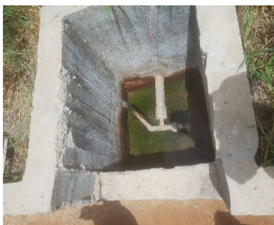
SORTIE DES EAUX USEES TRAITES AVANT INFILTRATION (A GAUCHE), BACHE DE STOCKAGE DES EAUX USEES TRAITES AVANT RELEVAGE POUR REUTILISATION (A DROITE), PS-EAU (MISSION JUIN 2022)
