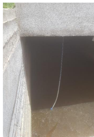
SORTIE DES EAUX USEES TRAITES AVANT INFILTRATION (A GAUCHE), BACHE DE STOCKAGE DES EAUX USEES TRAITES AVANT RELEVAGE POUR REUTILISATION (A DROITE), PS-EAU (MISSION JUIN 2022)
