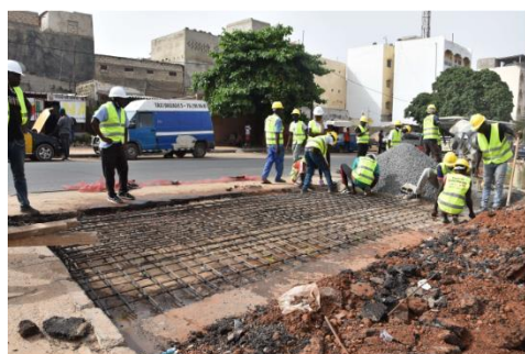
Réalisation d'arrêtoirs d'eau dans la commune de Wakhinane Nimzatt
