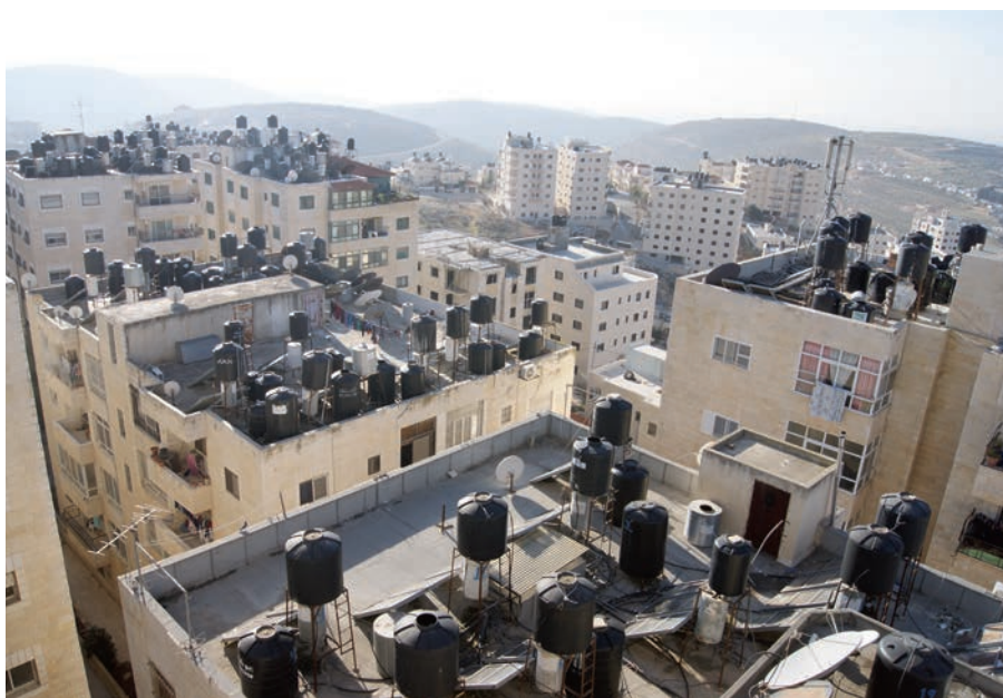
Des réservoirs sur les toits, palliatifs aux interruptions du service
