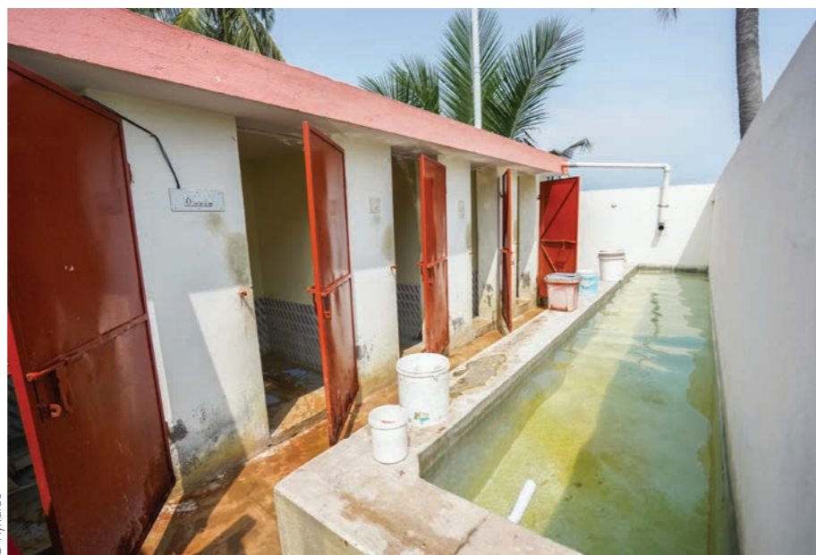
Les blocs de latrines
