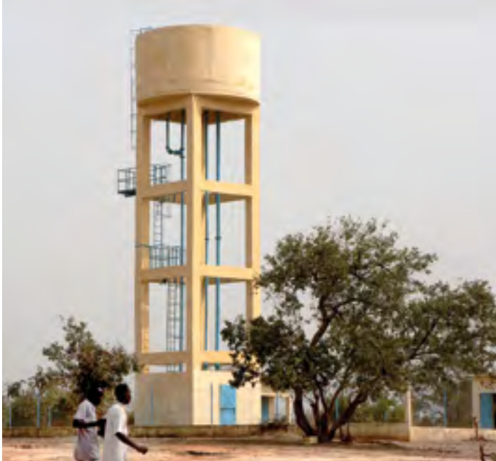
Le château d'eau de Thoumougel, d'une capacité de 50 m 3 .
