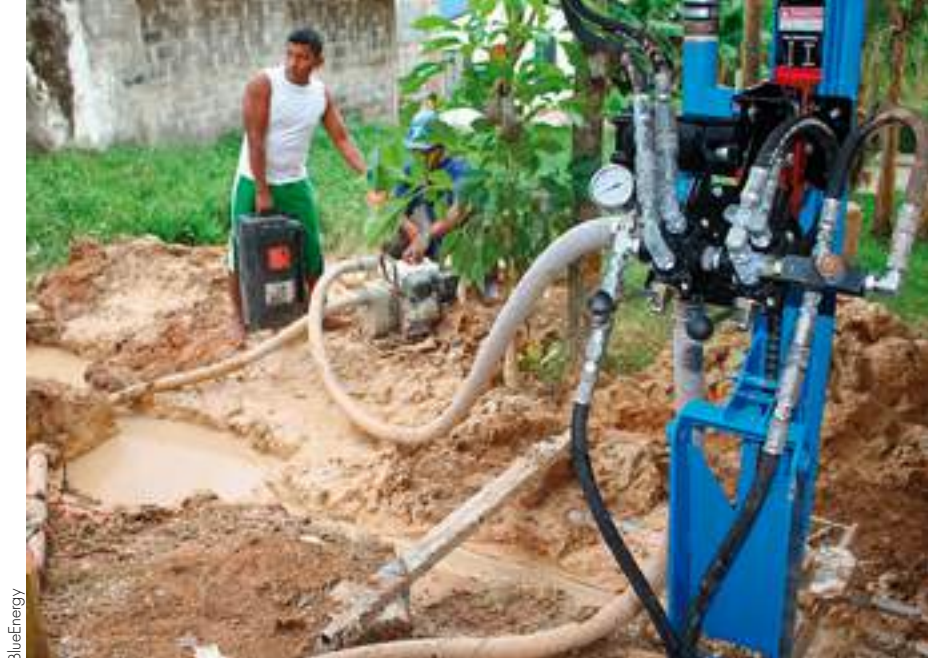
Forage mécanisé d'un puits.
