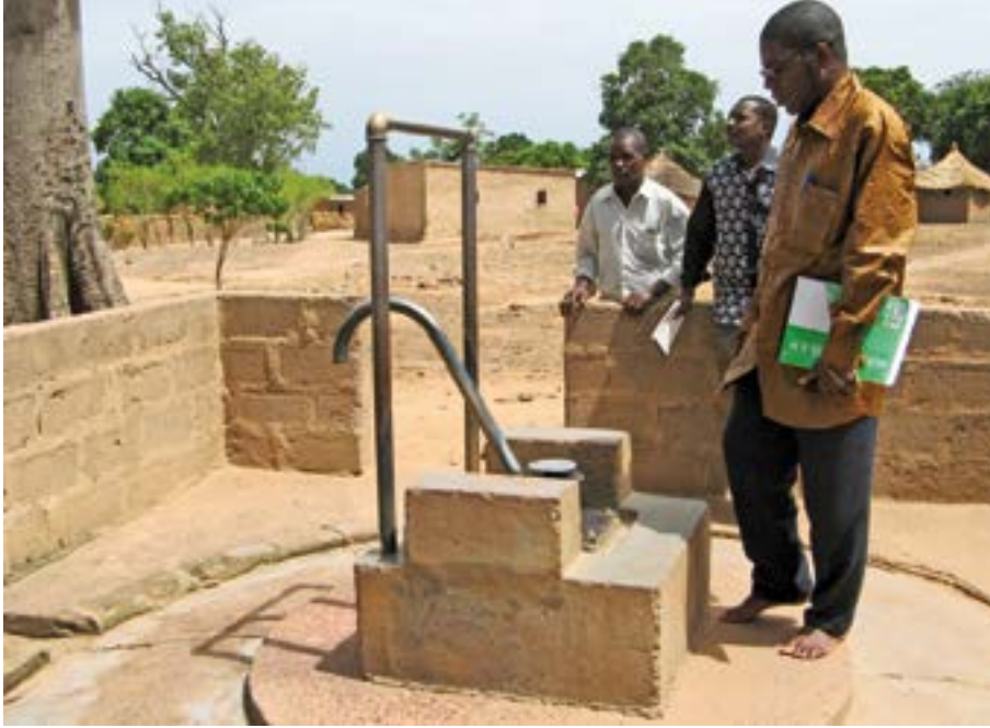
Pompe hydraulique dans la région de Bobo-Dioulasso.
