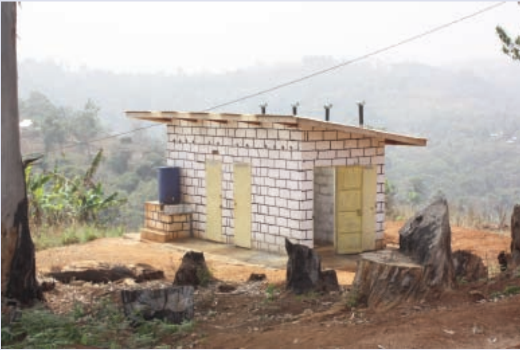
Dix écoles et cinq marchés ont été équipés de latrines écologiques comprenant deux fosses sèches qui permettent la récupération des urines, transformées ensuite en fertilisant agricole.
