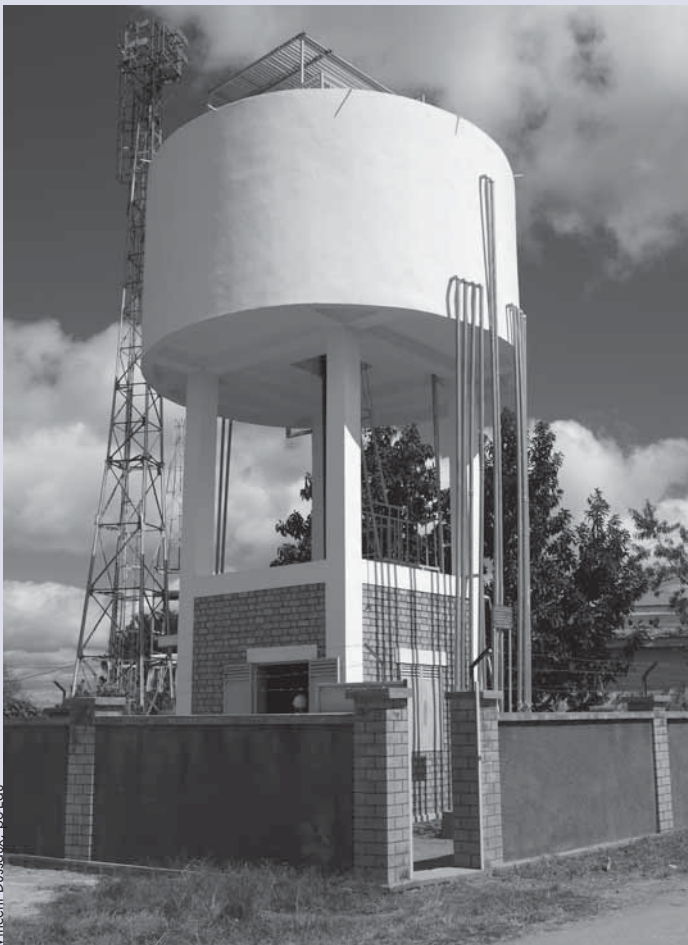
Nouveau réservoir en béton de 50 m 3
