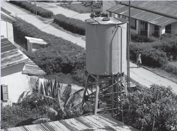
Ancien réservoir métallique de 9 m 3
