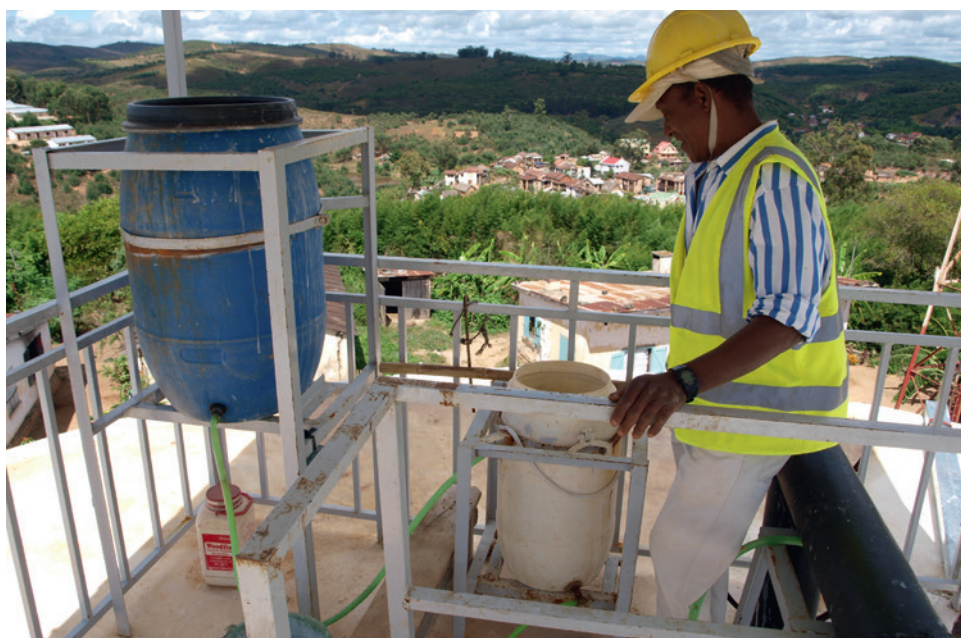
Chloration d'un réservoir d'eau potable à Madagascar
