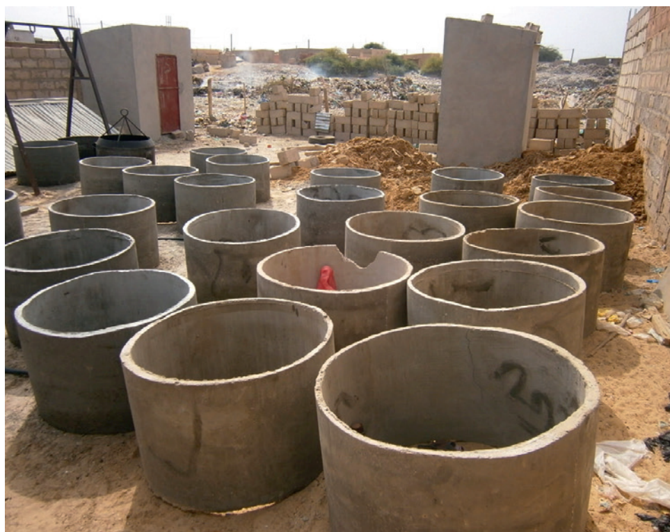
Construction de latrines en Mauritanie
