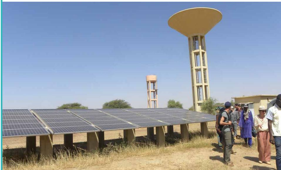
Passer d'un système thermique à un mix solaire/thermique permettrait de maintenir le niveau de distribution (128 113m<sup>3</sup>/an pour les besoins en eau potable et en maraichage), tout en diminuant le nombre d'heure de fonctionnement du groupe électrogène : passant de 8h par jour à 1h30 par jour. Ainsi, l'équipement solaire permettrait de faire fonctionner le système d'exhaure durant les 6h30 restantes.
