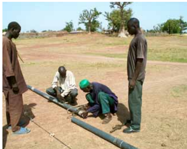
Figure 98. Travaux de réparation de forages dans le cadre du contrat de rivière Sourou, Burkina Faso (2007).
