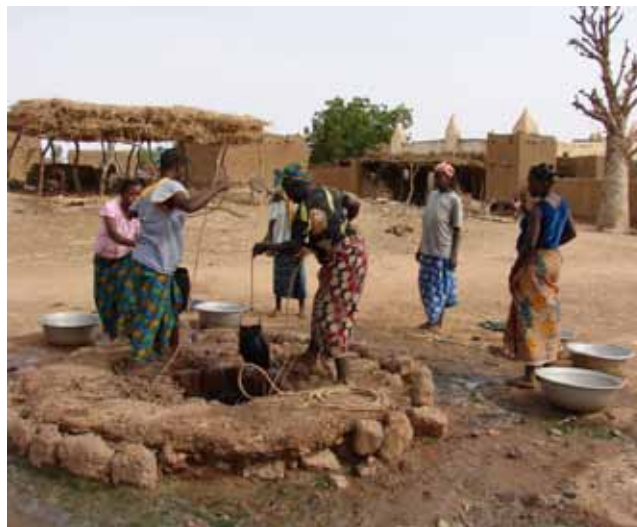
Figure 96. Puits à grand diamètre non protégé et risque de contamination fécale de l'eau, Burkina Faso (2009).
