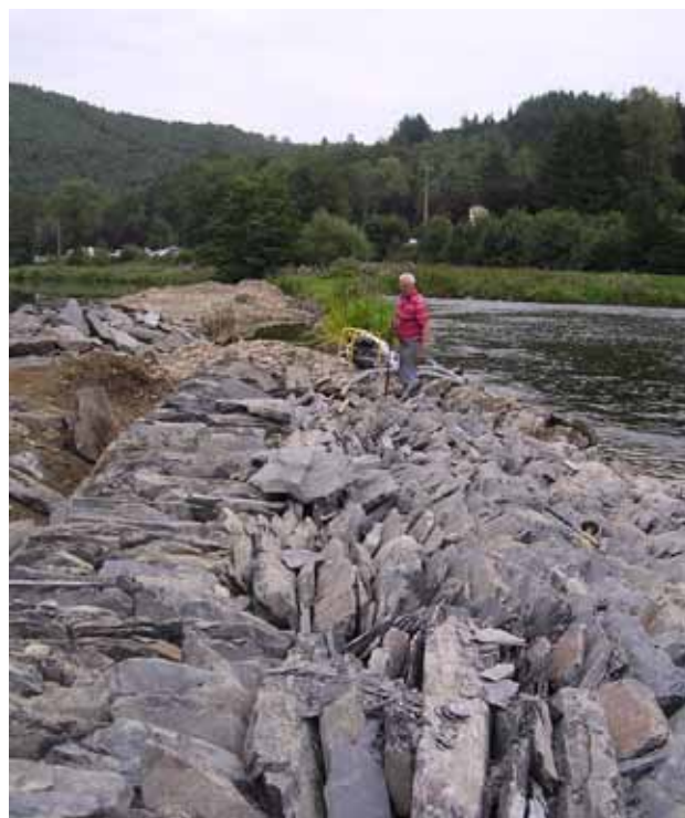
Figure 117. Chantier de restauration du barrage de Alle-sur-Semois (2006).
