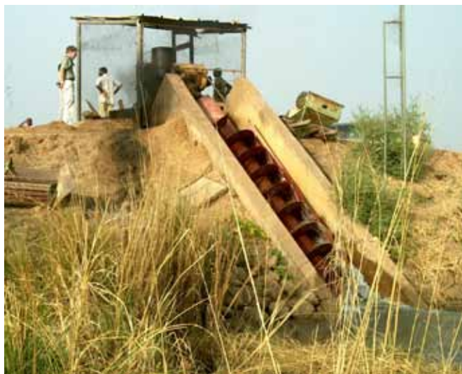
Figure 91. Inventaire des ouvrages hydrauliques dans le cadre du contrat de rivière Sourou au Burkina Faso (2004).
