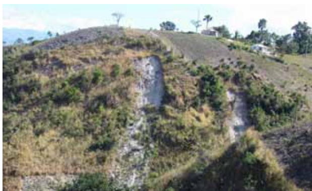
Figure 103. Erosion dans le bassin-versant de la rivière Moustiques, un problème complexe qui demande une coordination entre aménagement du territoire, occupation de sols et gestion de l'eau (2009).
