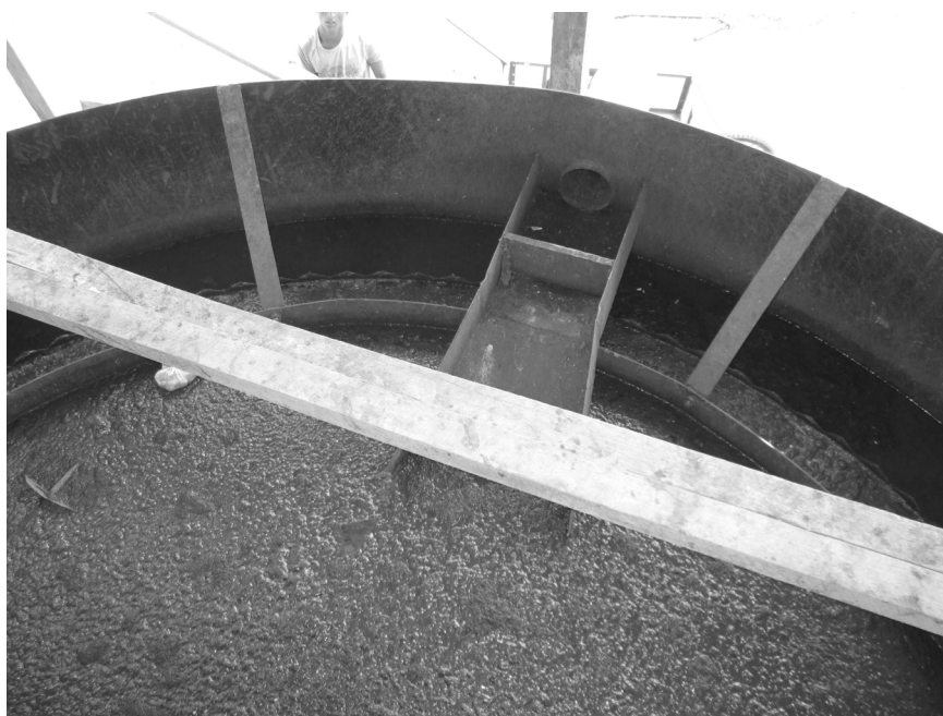
Foto 7.2 Arreglo para la remoción de espuma, tanque con fondo tipo tolva de Sittwe
