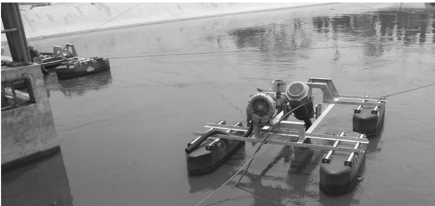
Foto 8.2 Aireador de superficie de alta velocidad en Duri Kosambi, Yakarta
