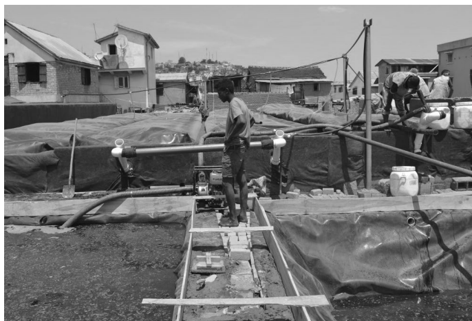
Foto 6.10 Digestor de bolsa de geotextil en Antananarivo (Madagascar) Fuente: foto de Georges Mikhael
