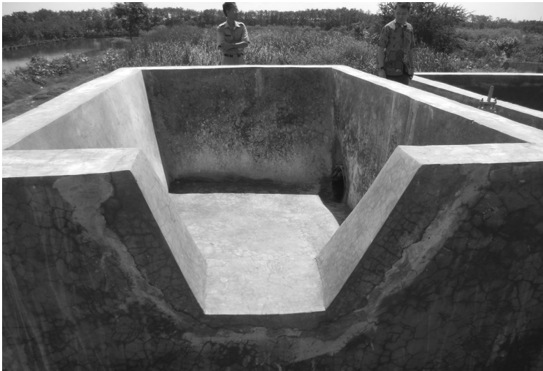
Foto 6.2 Cámara de recepción de lodos sépticos, Tegal (Indonesia)
