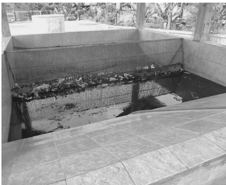
Foto 5.2 Rejas verticales sin acceso para el operador
