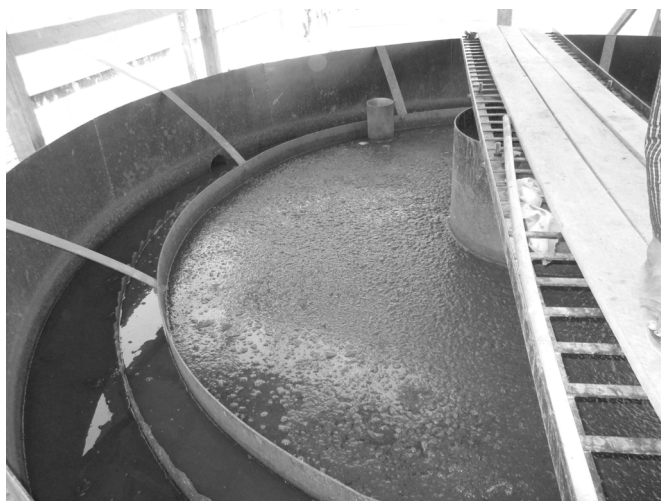
Foto 7.1 Espesador por gravedad con fondo tipo tolva en Sittwe (Myanmar)
