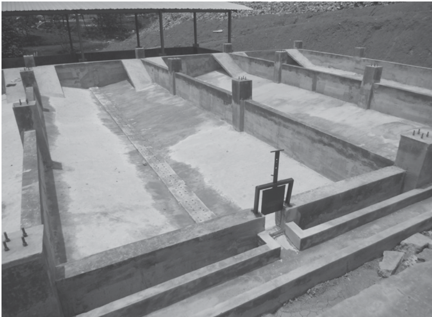
Photo 9.1 Lits de séchage en construction
