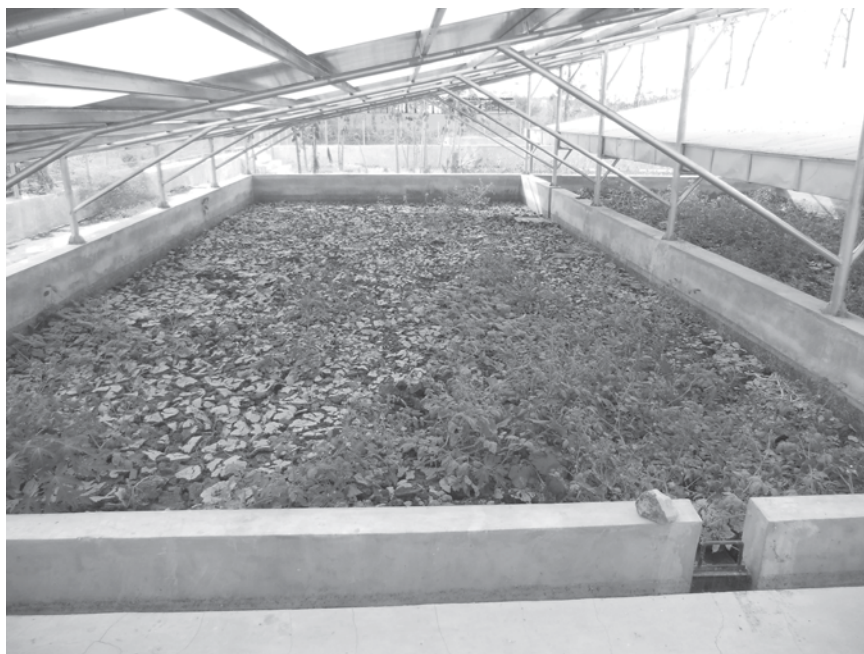
Photo 9.2 Couverture d'un lit de séchage à Jombang en Indonésie
