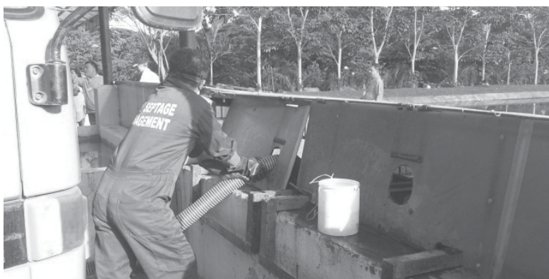
Photo 6.4 Zone de dépotage avec un couvercle de protection rabattable à Dumaguete (Philippines)
