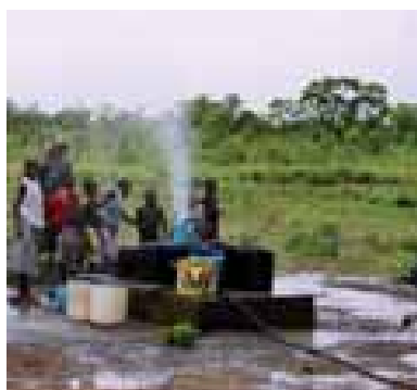
Redéveloppement au compresseur
