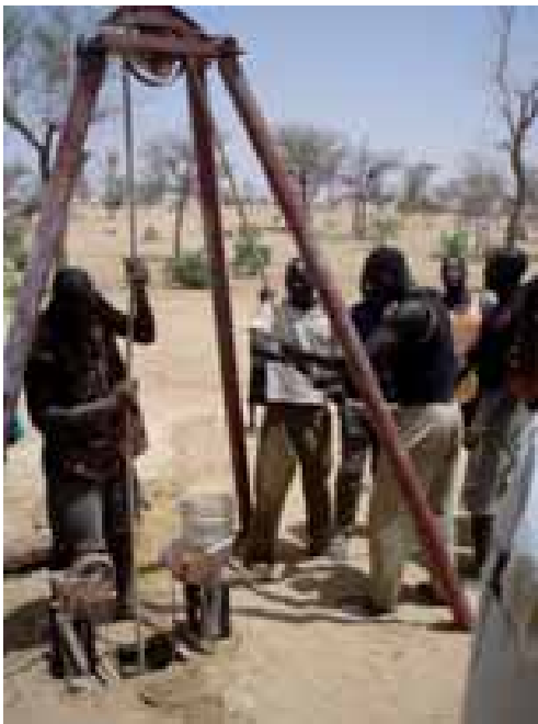
Outil de battage manuel au trépan
