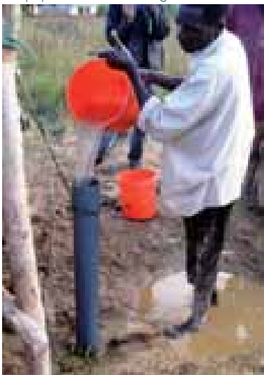
Rinçage du forage à l'eau
