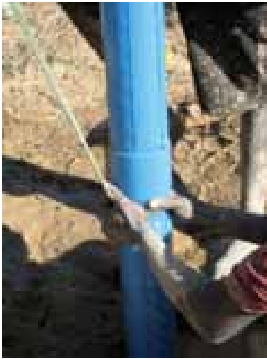
Utilisation d'une corde pendant l'équipement d'un forage
