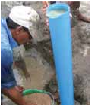
En versant le gravier dans le trou de forage, l'eau déborde du tubage
