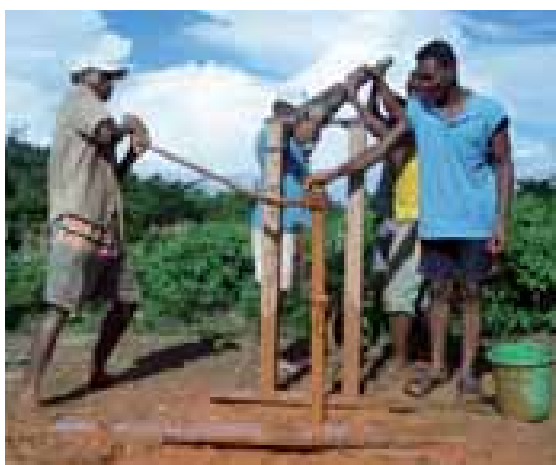
La foreuse rotative à boue en action
