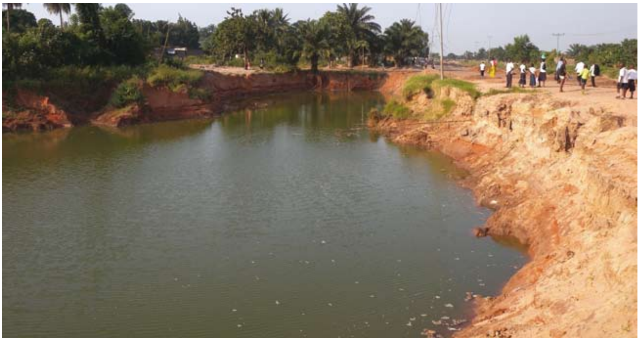
Le directeur du centre REGIDESO de Lisala observe la station d'épuration détruite d'Ebabo, autrefois située dans une forêt protégée. L'extension des habitations et des activités agricoles ont conduit à la sédimentation du ruisseau qui alimentait la station
