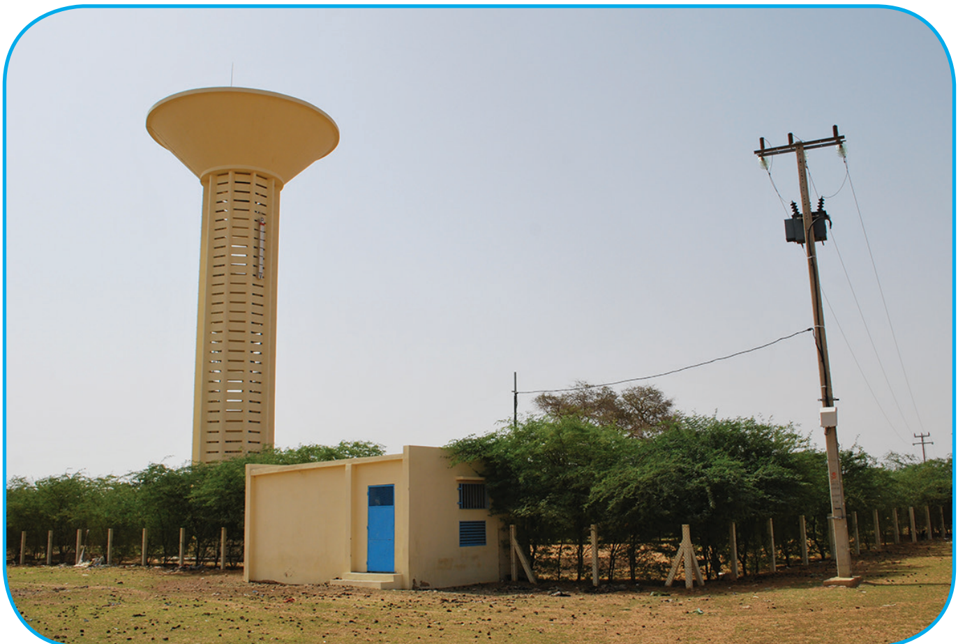
Forage électrifié à Keur Madialé (Louga)
