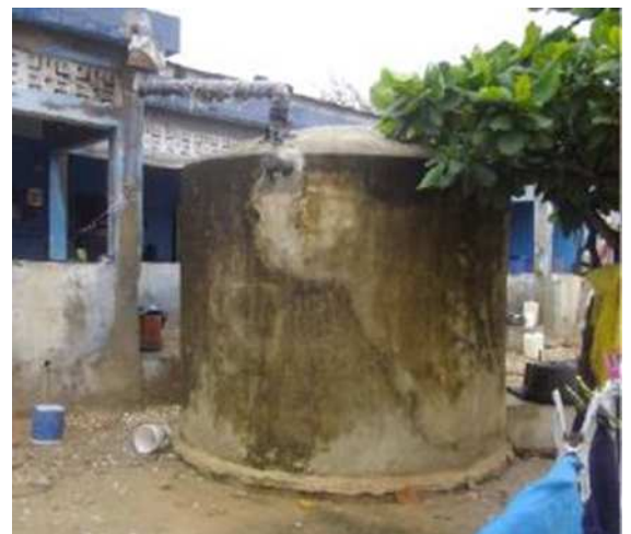
CEP de 10 m 3 à Moundé réalisé par Caritas
