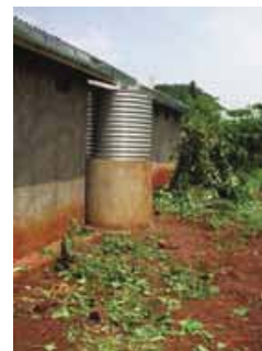
Réservoir de captage de l'eau de pluie
