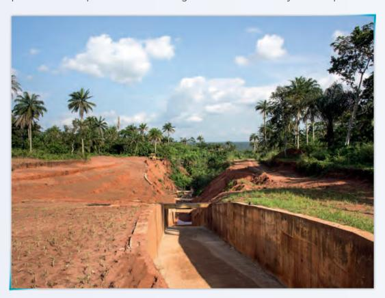
Ouvrage d'assainissement des eaux pluviales et de lutte contre l'érosion, Nigéria
