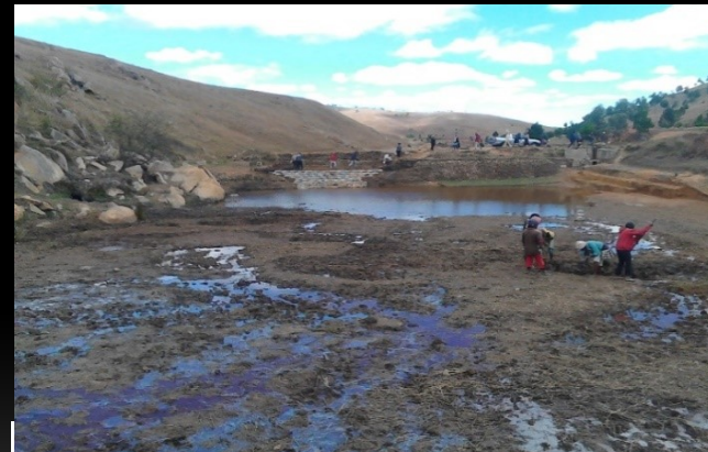
Aménagement du bassin
