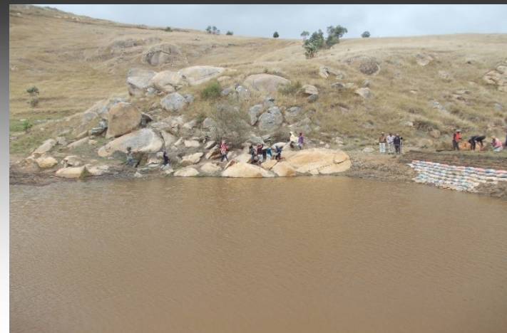
Réalisation des travaux à 80%
