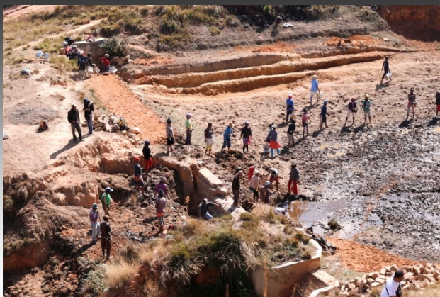
Réhabilitation du barrage
