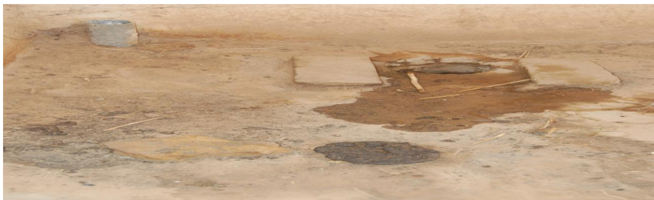
Photo 6 : Latrine mal entretenue dans une école primaire (ONG Mungané, 2017)
