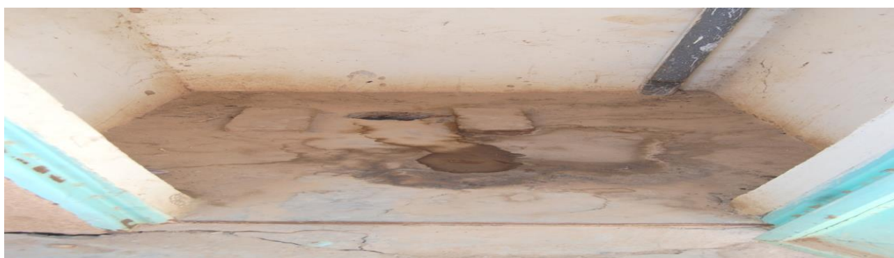
Photo 7 : Latrines présentant le risque d'effondrement (ONG MUNGANE, 2017)
