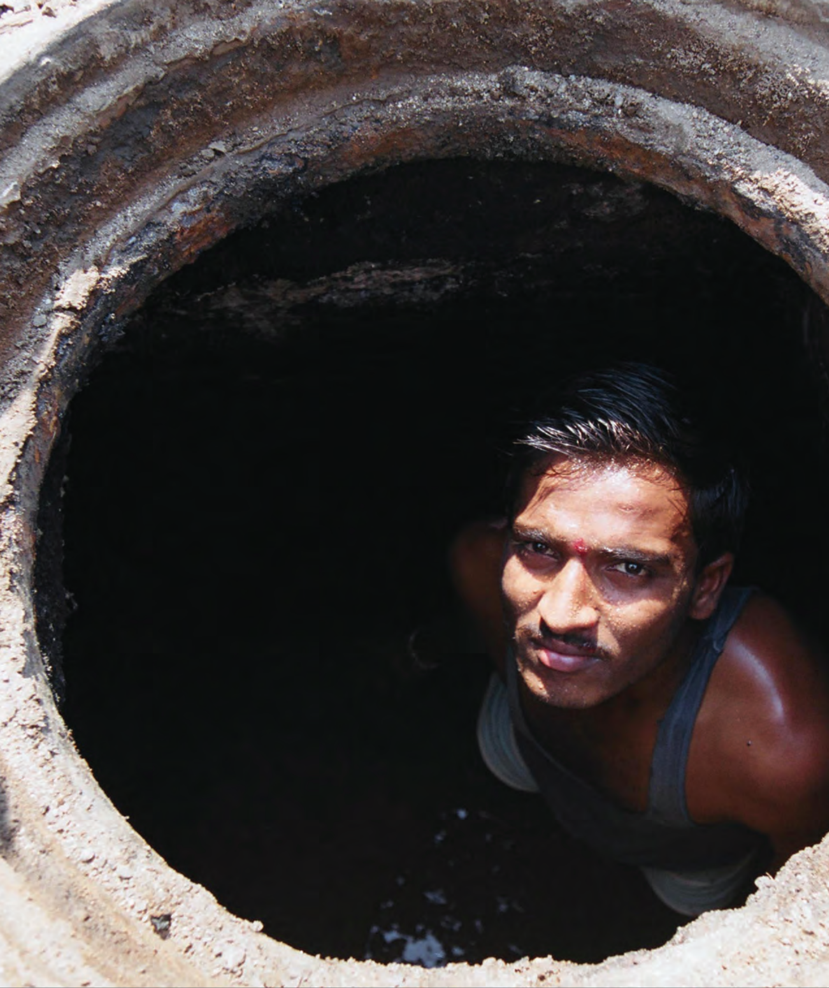
Prakash, égoutier à Hyderabad, travaille sans aucune protection : ni gants, ni combinaison, ni bottes. Il racle et nettoie les conduites des égouts au moyen de ses mains et de ses pieds. Inde, M. Crozet, 2002. © OIT. Photo utilisée avec l'autorisation de l'auteur. Réutilisation soumise à autorisation.
