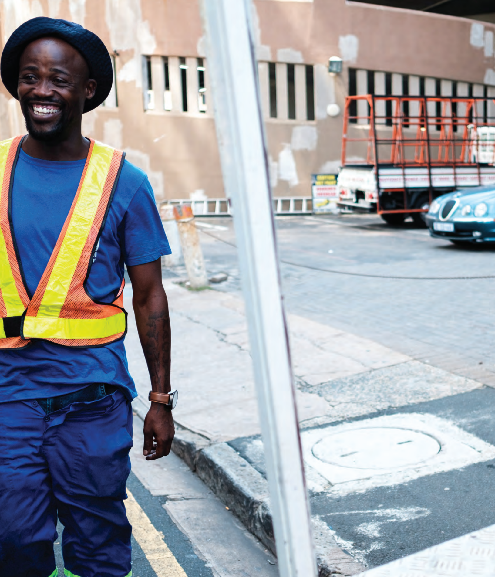
Christopher Magubane (36 ans, à gauche) et Senzi Dumakude (32 ans, à droite), membres d'une équipe en charge du débouchage des égouts à Durban, dans la municipalité d'eThekweni. Leur équipe se sert de tiges flexibles pour déboucher les canalisations qui mènent aux principales conduites d'égouts. Afrique du Sud, mars 2019. © WaterAid / Nyani Quarmyne. Photo utilisée avec l'autorisation de l'auteur. Réutilisation soumise à autorisation.
