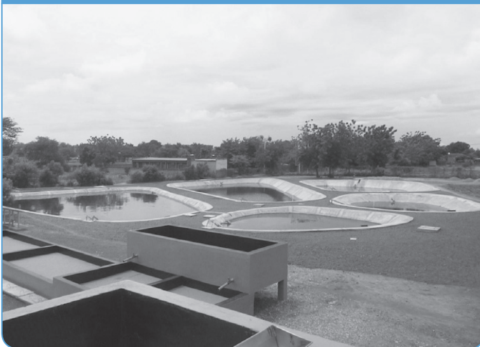
Vue d'ensemble de la station d'épuration du 2iE
