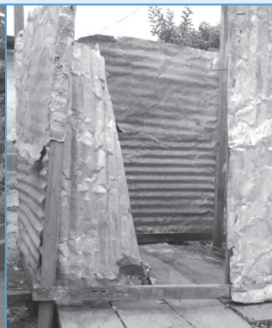
Latrine à canon
