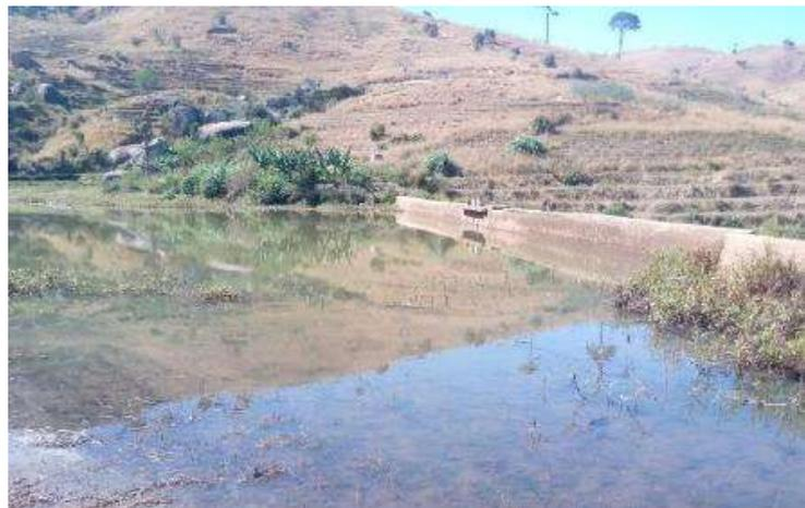
**Figure 10 : Barrage comblé par les sédiments ©Eaurizon**
