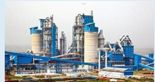
Cimenterie du Sahel
