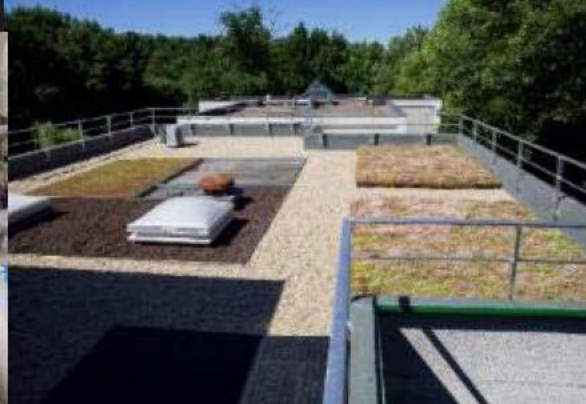
Stockage eaux pluviales
