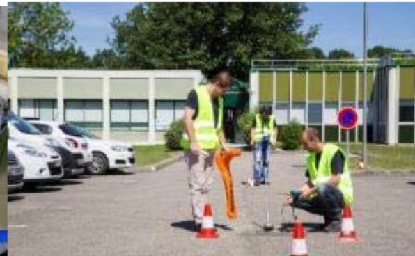
Recherche de fuites
