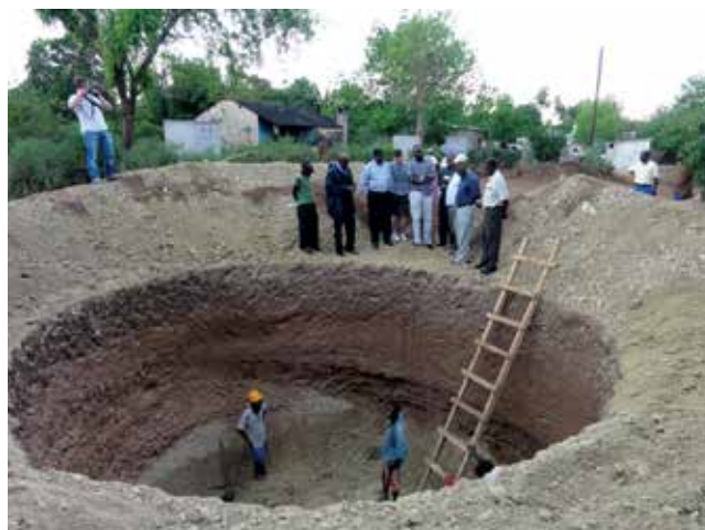
Construção de latrina de biogás que faz parte das obras iniciadas pelo Devolution Trust Fund em Libuyu, Livingstone (Zâmbia), novembro de 2011
