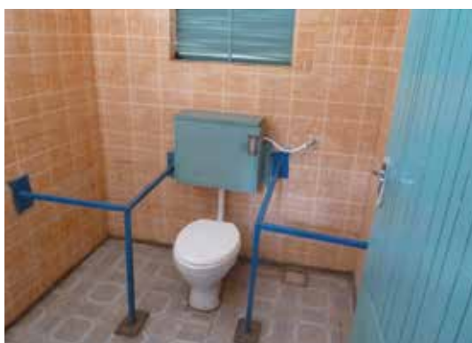
Uma retrete concebida para utilizadores com deficiência numa instalação sanitária pública construída pela Nanyuki Water and Sewerage Company, Nanyuki, Quênia
