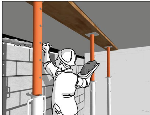
**5.** Cas E1 toiture en béton Ajouter une couche de mortier sur la dernière rangée de bloc avant d'enlever les étais.
