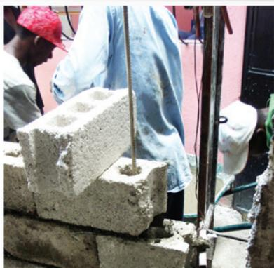
**Description** – Le coulis de béton pour le remplissage des cellules en maçonnerie de blocs peut être réalisé sur place ou produit ailleurs et amené sur le terrain.
