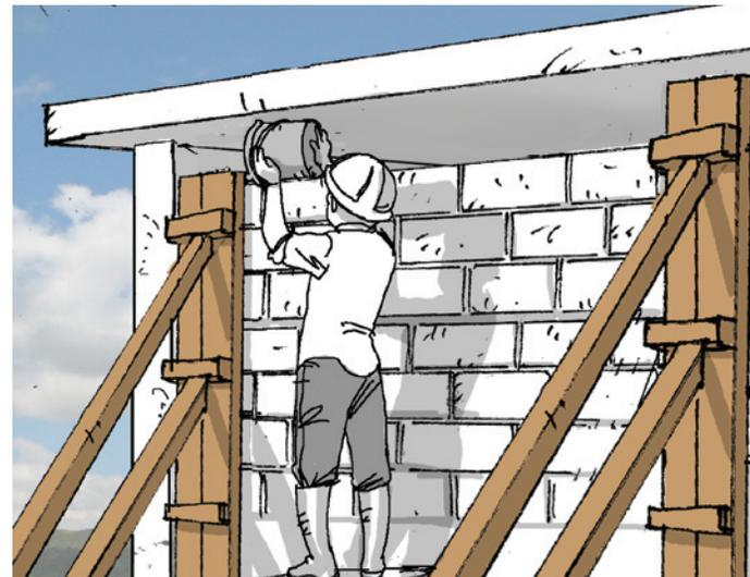
**8.** Avant la pose de la dernière rangée de blocs, laisser l'extrémité libre et couler le béton au bout dans les cellules des blocs contenant une armature verticale.
