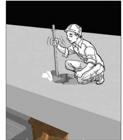
8. Préparer le coulis de béton et le verser dans les cellules extrêmes contenant l'armature. Utiliser une tige de fer ou un vibreur pour tasser le coulis de béton dans les cellules. Vibrer le coulis de béton jusqu'à ce qu'aucune bulle d'air ne soit observée (10 à 30 secondes) ou tasser avec une tige de fer au moins 10 fois.
