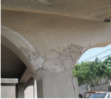
**Description** – Écaillage de couche de béton au sommet et au bas d'une colonne avec noyau de béton et armatures intacts.
