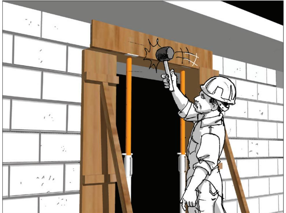
**5.** Tasser le béton avec une tige de fer et / ou utiliser un marteau en caoutchouc, jusqu'à ce qu'aucune bulle d'air ne soit observée (10-30 secondes)
