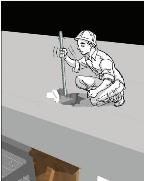
**7.** Préparer du coulis de béton et le verser dans les cellules des blocs contenant une armature verticale. Tasser le coulis de béton avec une tige de fer ou utiliser un vibreur jusqu'à ce qu'aucune bulle d'air ne soit observée (10-30 secondes)
