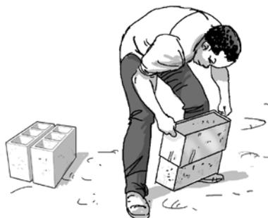
5. Retourner le moule sur le sol et le retirer avec soin, pour laisser le nouveau bloc.
