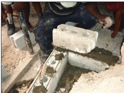
**Description** – Le mortier de ciment est un élément important dans la construction en maçonnerie. Il est le lien qui relie ensemble les éléments (blocs de béton, moellons). Des matériaux de bonne qualité sont importants pour la production d'un bon mortier.
