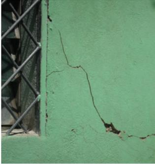
**Description** – Les fissures d’enduit des murs, partent généralement des ouvertures et des angles sont dans un rayonement à partir des ouvertures et sont de 1,5 mm d’épaisseur maximum. Elles se produisent aussi à l’intersection des murs, aux colonnes, au plafond ou au plancher.
