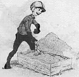
Avant de cimenter la première rangée, disposer les blocs sur la longueur du mur pour définir le patron de pose.
